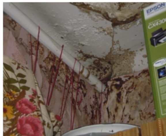
Биопоражение на стене и потолке
